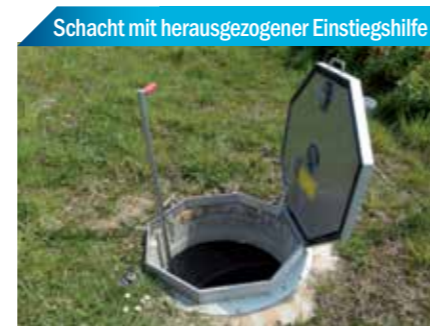
Schacht mit Einstiegshilfe
